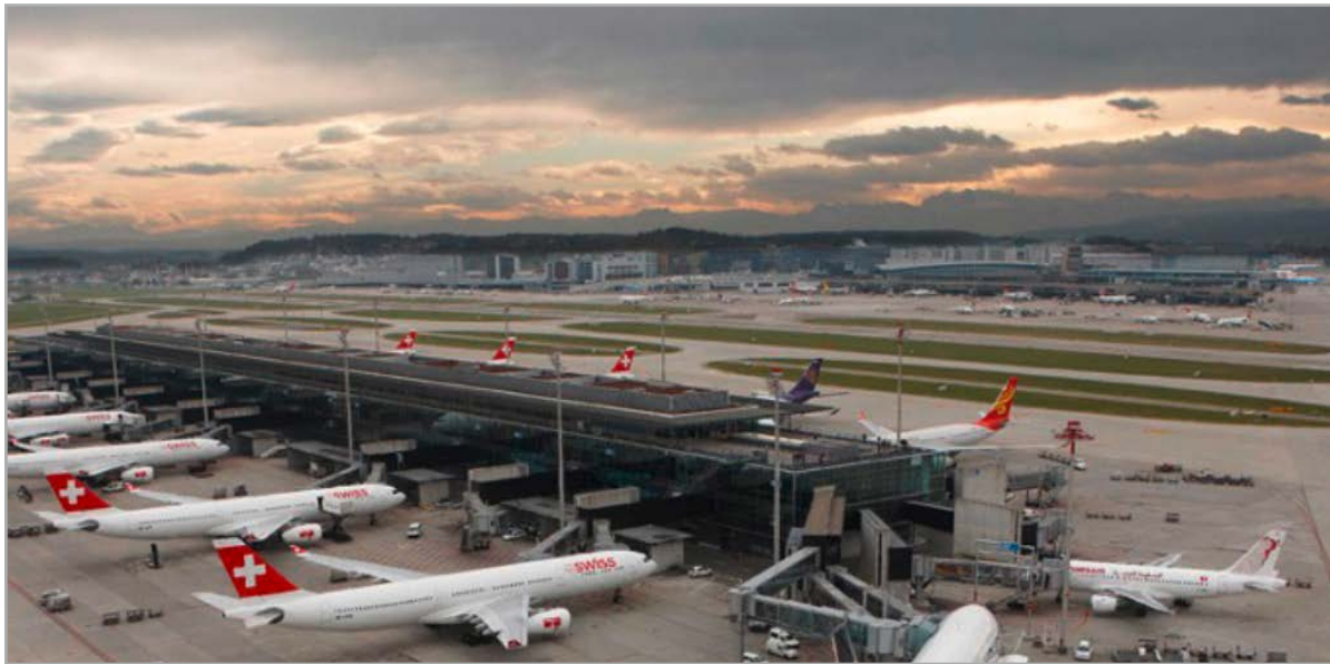
▲ Abb. 1: Der Flughafen Zürich baut bei seinen Neubauten auf Geothermie – hier Terminal E.
