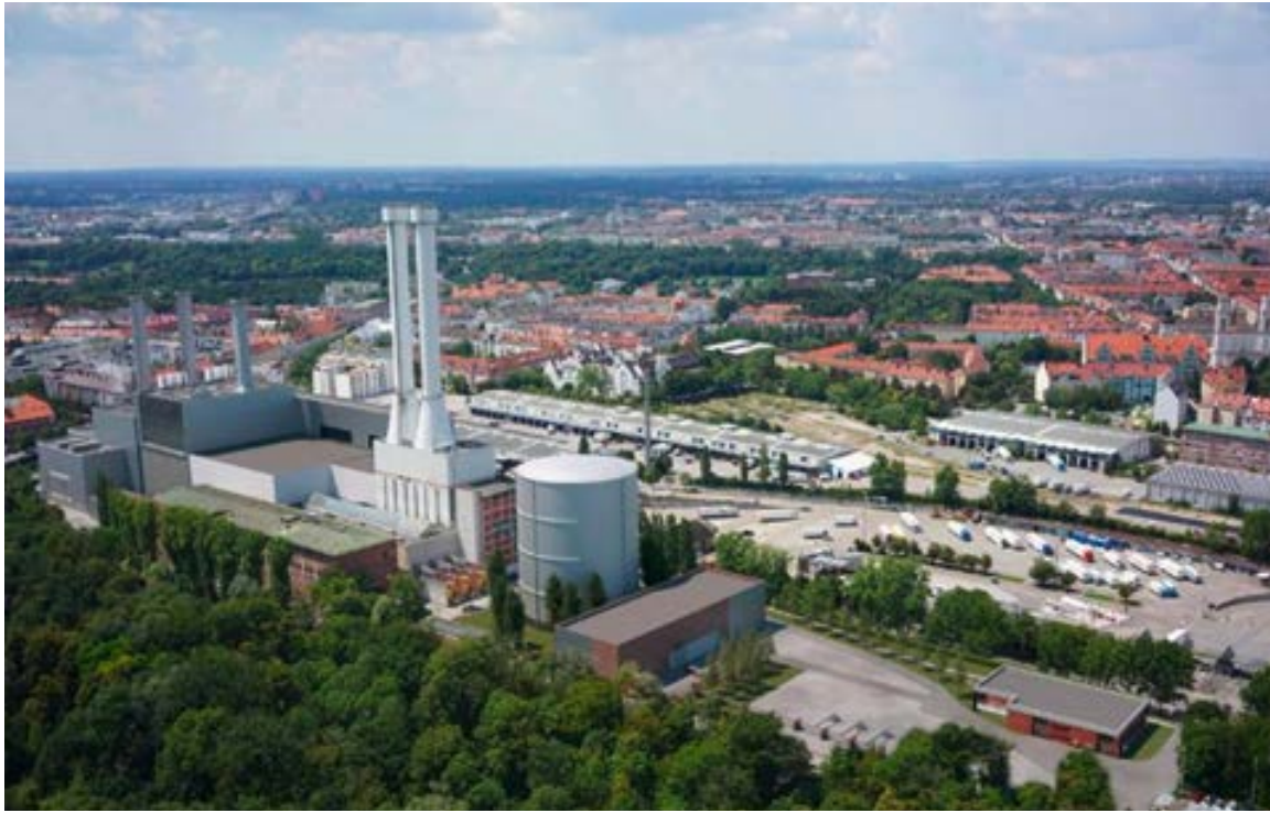
◀ Abb. 1: Die Visualisierung zeigt den SWM Energiestandort Süd an der Schäftlarnstraße mit dem aktuell im Bau befindlichen Wärmespeicher (weiß, Bildmitte). Neben der klassischen Energieerzeugung mittels Gas- und Dampfturbinen wird dort seit 2021 geothermische Wärme ins Fernwärmenetz eingespeist.
